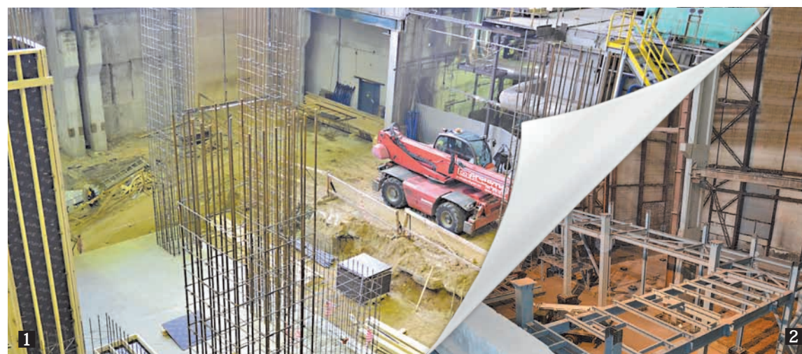
1. Фундамент для паровой турбины 2. Каркас для будущего корьевого котла
